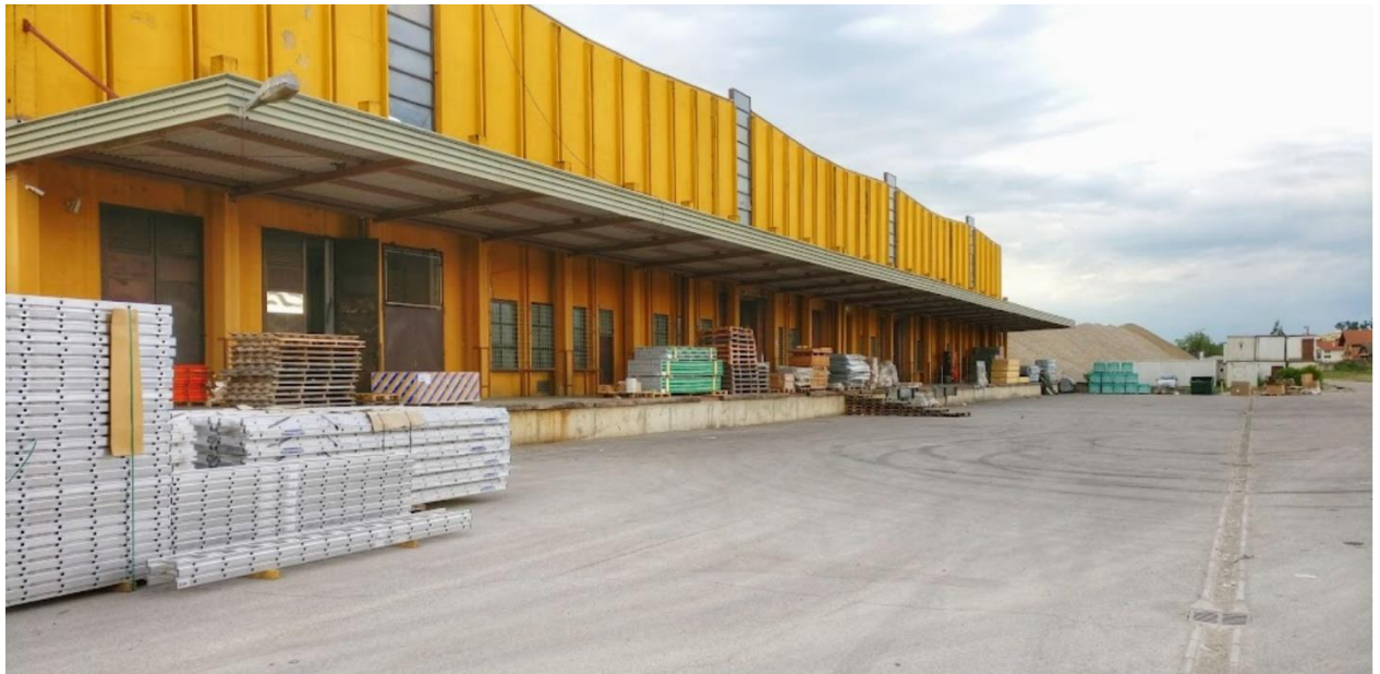
Slika 20. PeveX d.d. – Centralno skladište
