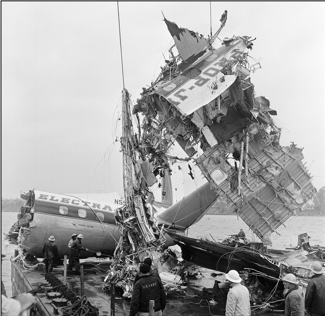
Slika 29. Dijelovi Lockheed L-188A Electra nakon udara ptica, [29]
