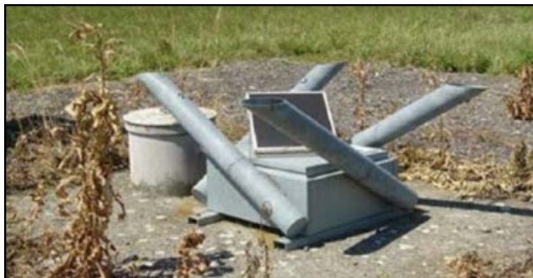
Slika 51. Podzemni stacionarni generator buke, [31]
