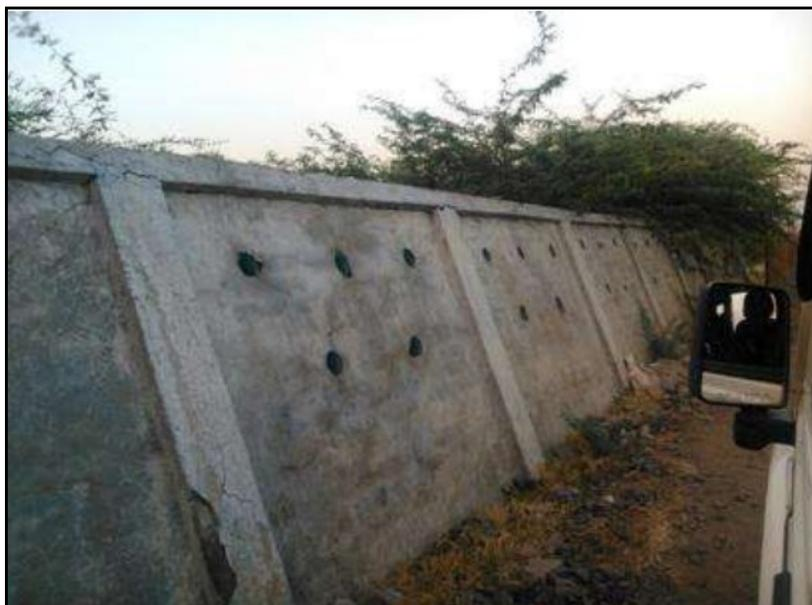
**Slika 21.** Nagnut i oštećen zid na zračnoj luci Surat, [25]
