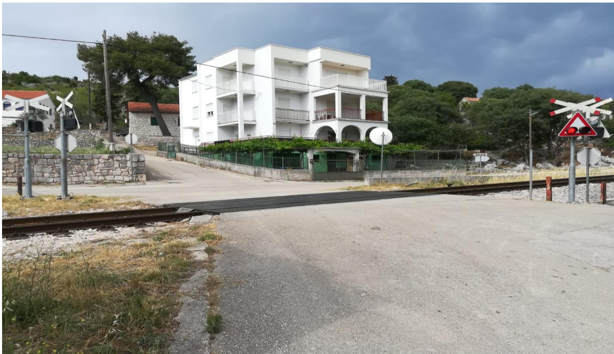
Slika 30. Željezničko-cestovni prijelaz „Fratrov“ iz smjera zapada
