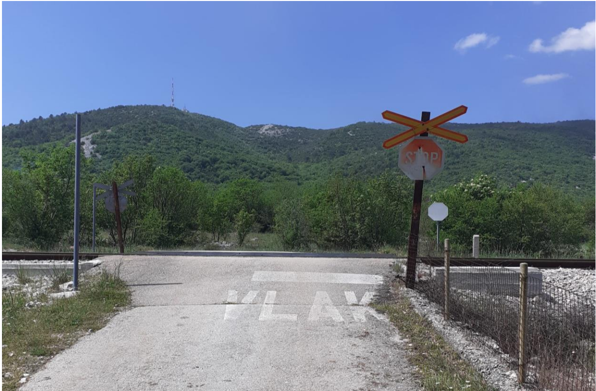
Slika 37. Željezničko-cestovni prijelaz „Labin“ iz smjera istoka
