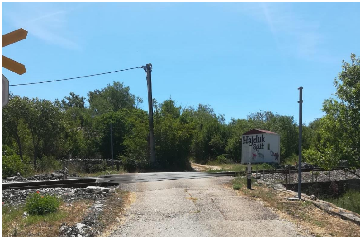
Slika 33. Željezničko-cestovni prijelaz „Runjići“ iz smjera istoka
