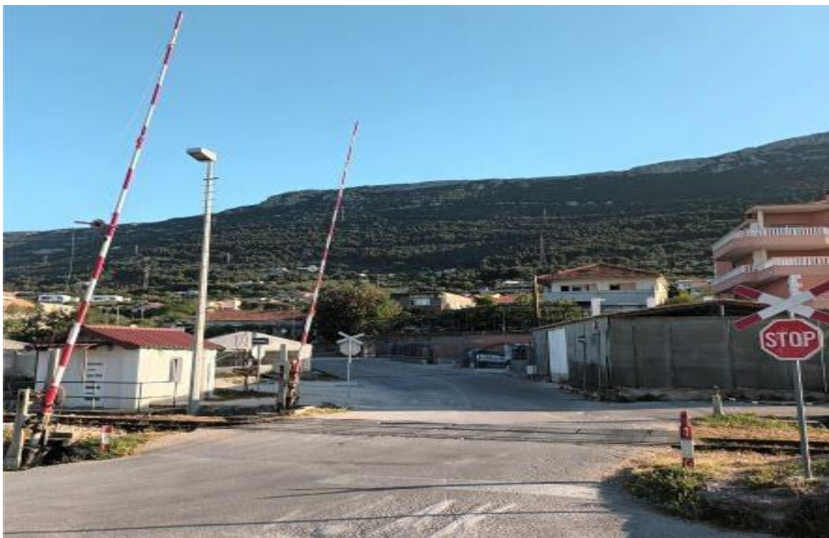
Slika 50. Željezničko-cestovni prijelaz „Kaštel Stari 1“ iz smjera zapada Izvor: Autor
