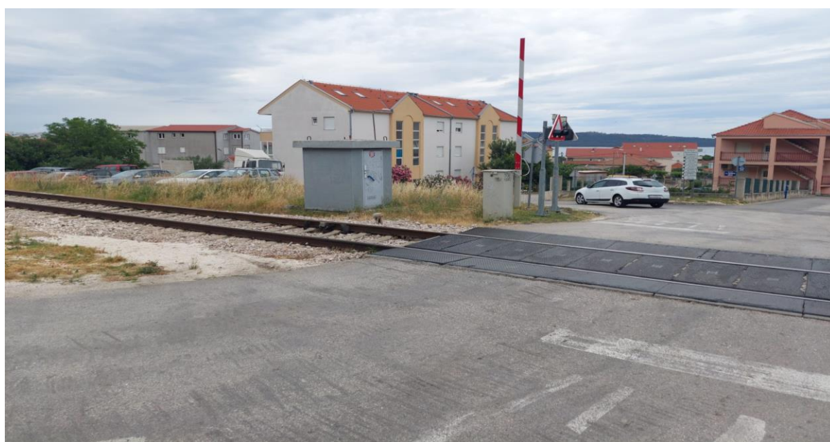
Slika 69. Željezničko-cestovni prijelaz „Kaštel Gomilica“ iz smjera istoka
