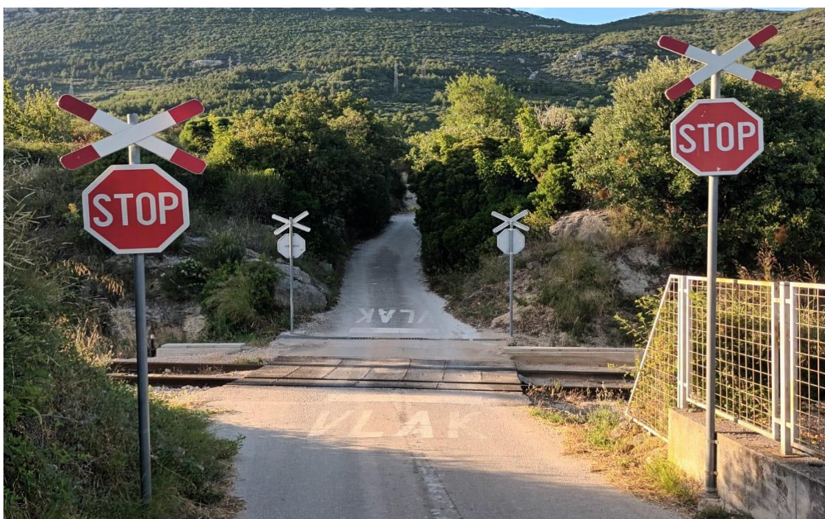
Slika 58. Željezničko-cestovni prijelaz „Kaštel Stari“ iz smjera zapada
