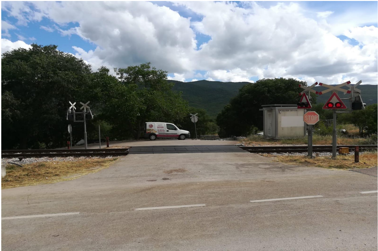
Slika 29. Željezničko-cestovni prijelaz „Fratrov“ iz smjera istok
