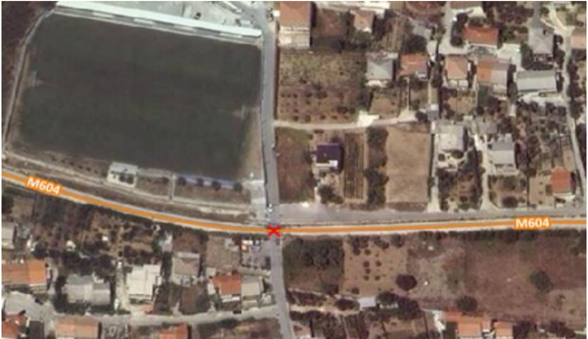
Slika 72. Željezničko-cestovni prijelaz „Jadransko igralište“ Izvor: [14]
