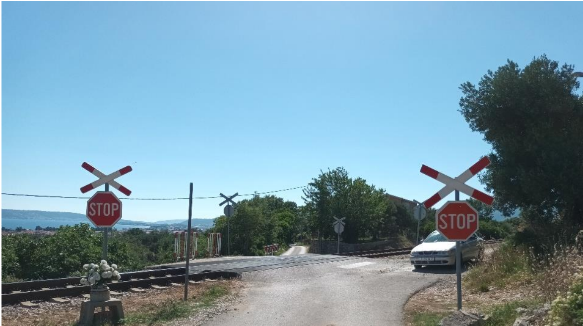
Slika 65. Željezničko-cestovni prijelaz „Kaštel Lukšić mali“ iz smjera istoka
