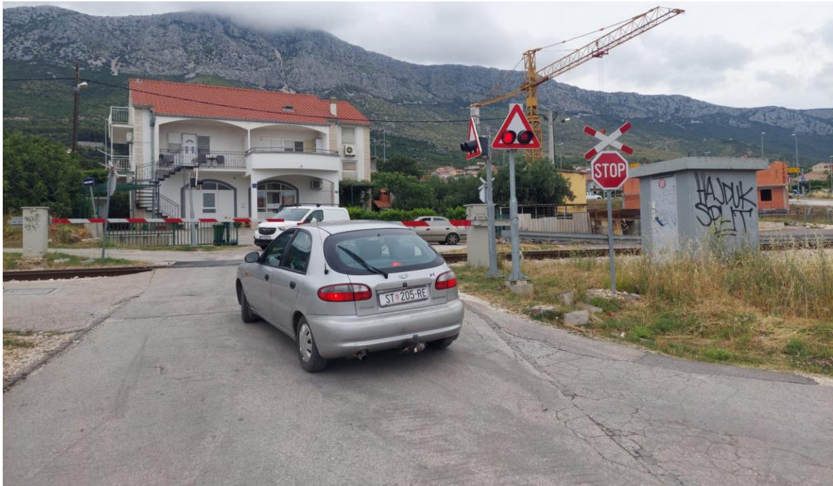
Slika 70. Željezničko-cestovni prijelaz „Kaštel Gomilica“ iz smjera zapada
