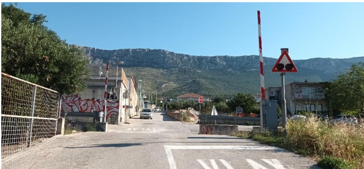
Slika 74. Željezničko-cestovni prijelaz „Jadranovo igralište“ iz smjera zapada
