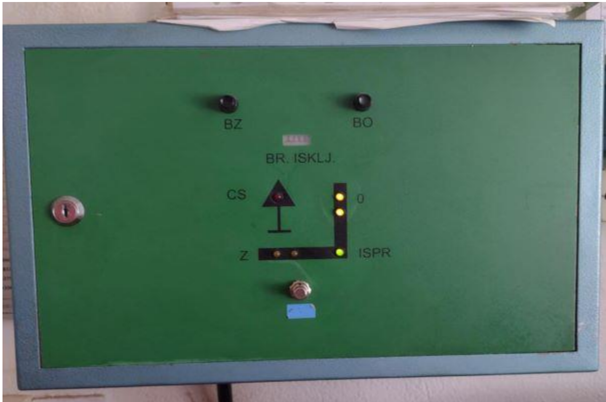
Slika 92. Prikaz kontrolno-upravljačkog pulta u prometnom uredu Kaštel Sućurac Izvor: Autor
