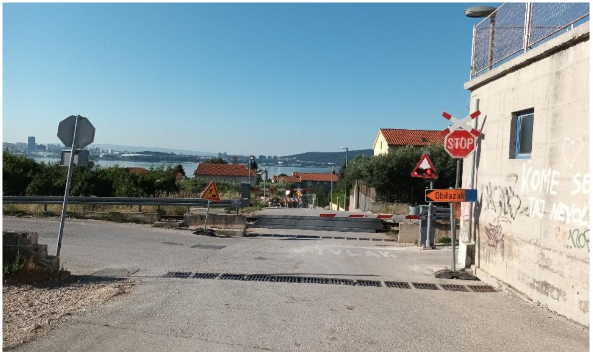
Slika 73. Željezničko-cestovni prijelaz „Jadransko igralište“ iz smjera istoka
