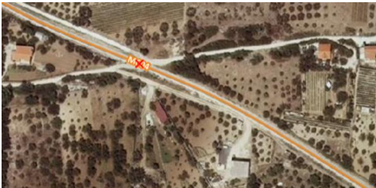
Slika 64. Željezničko-cestovni prijelaz „Kaštel Lukšić mali“
