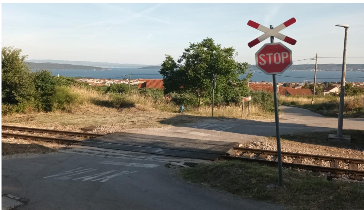
Slika 53. Željezničko-cestovni prijelaz „Kaštel Stari 2“ iz smjera istoka
