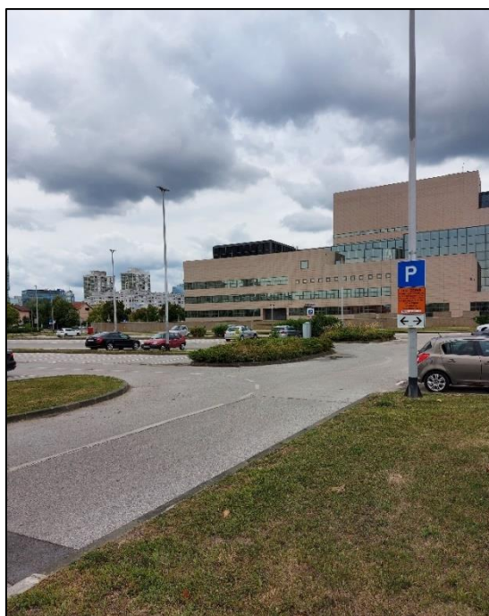
Slika 37: Zona IV.2, Parkiralište kod Nacionalne knjižnice (Lokacija: Slika 32., broj 5.)
