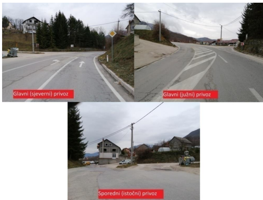
Slika 31. Pogled na privoze raskrižja
