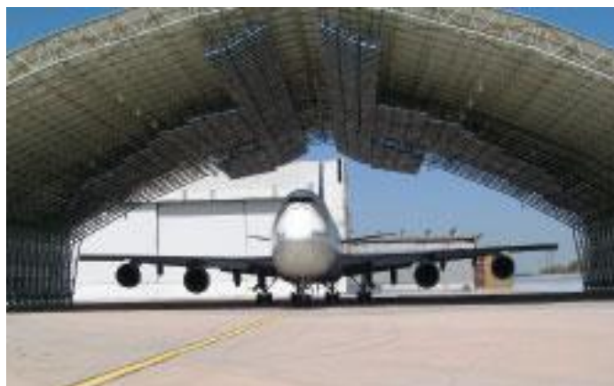
Slika 19. Hangar za odleđivanje zrakoplovnih površina, [45]
