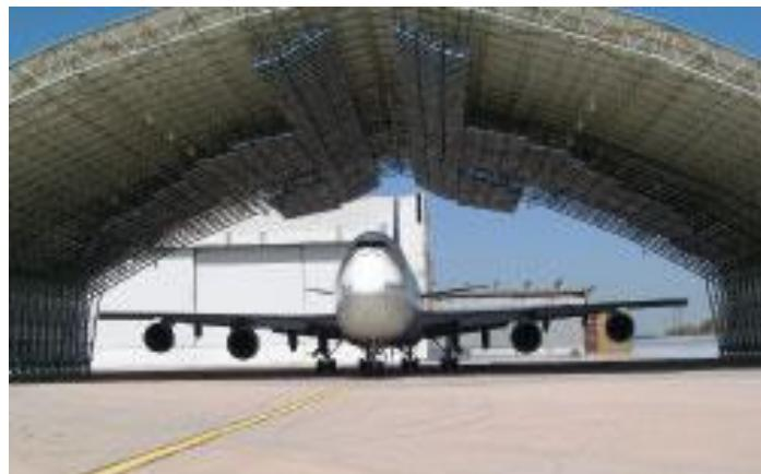
**Slika 19.** Hangar za odleđivanje zrakoplovnih površina, [45]
