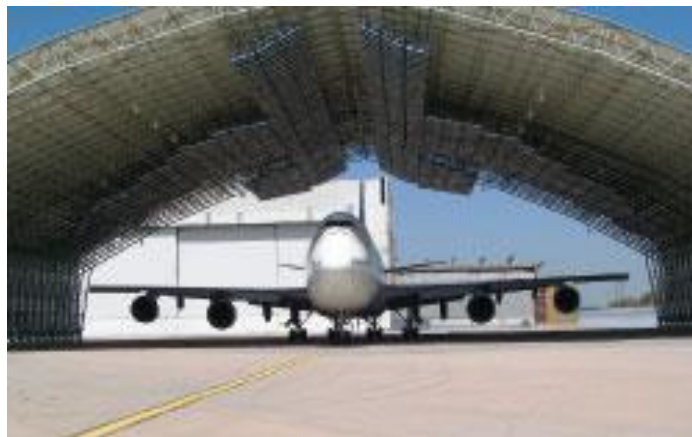
Slika 19. Hangar za odleđivanje zrakoplovnih površina, [45]
