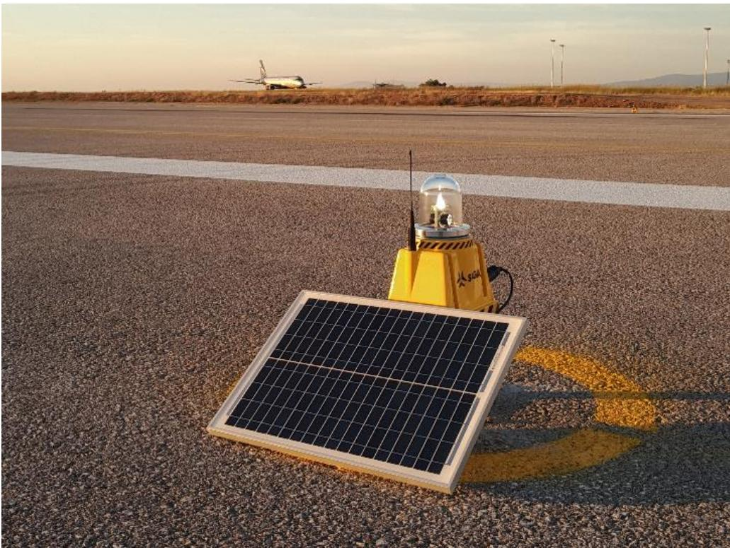
**Slika 11.** LED rasvjeta sa solarnim sustavom, [65]
