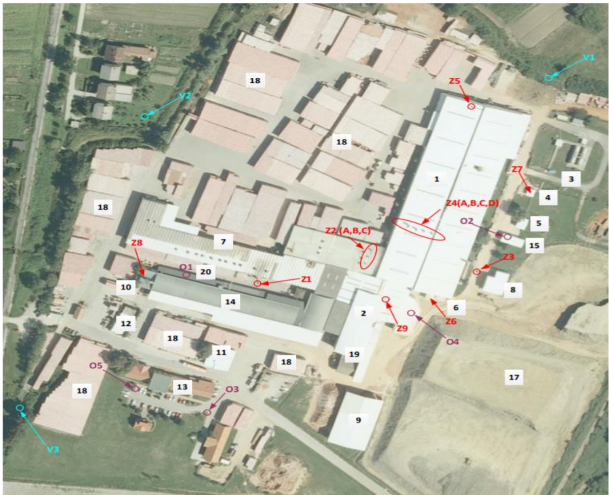
Slika 22: Wienerberger kompleks s označenim objektima
