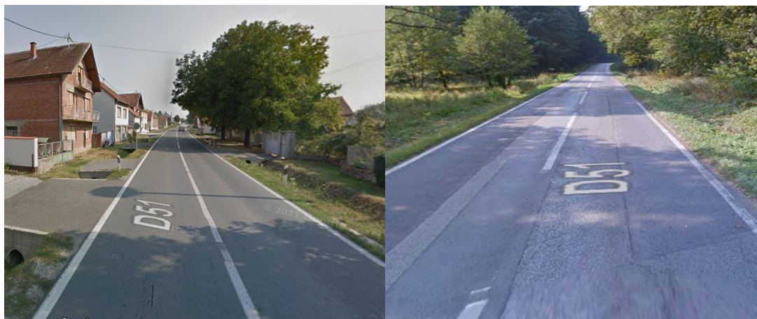
Slika 27. OM Eminovci – prije sanacije
