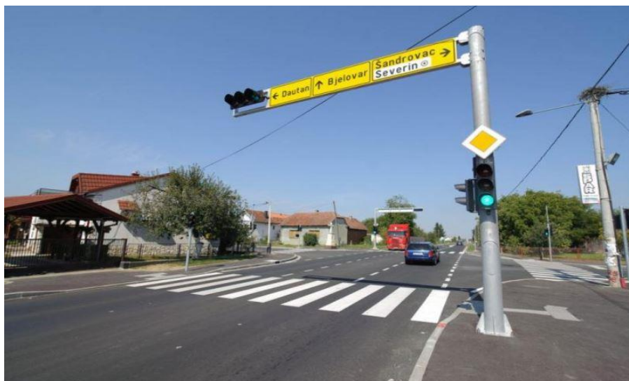
Slika 19. OM Severin – poslije sanacije
