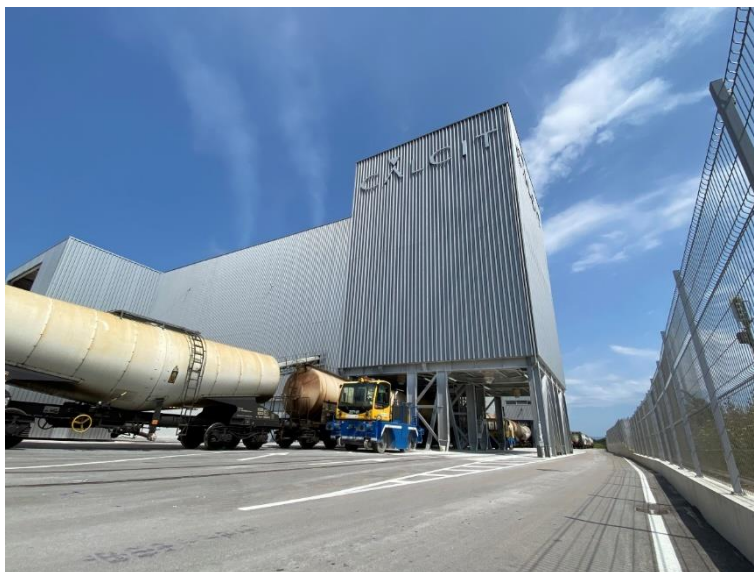
Slika 13. Silos suhih proizvoda
