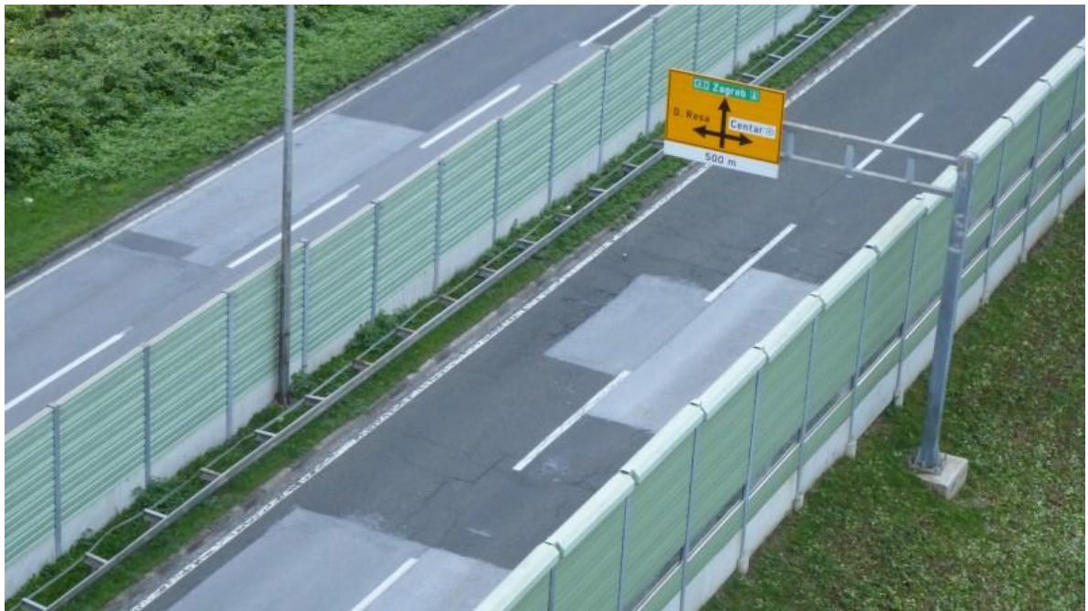
Slika 12: Uređaj za zaštitu od buke na autocesti
