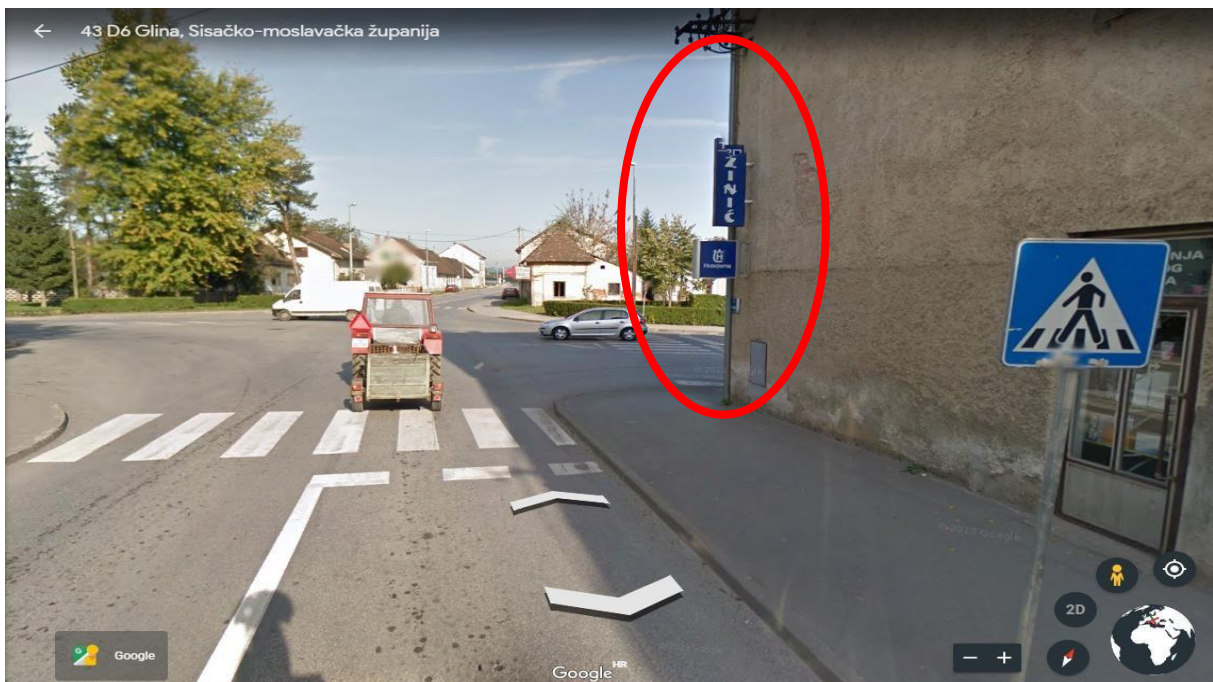
Slika 15. Prikaz infrastrukture koja smanjuje preglednost
