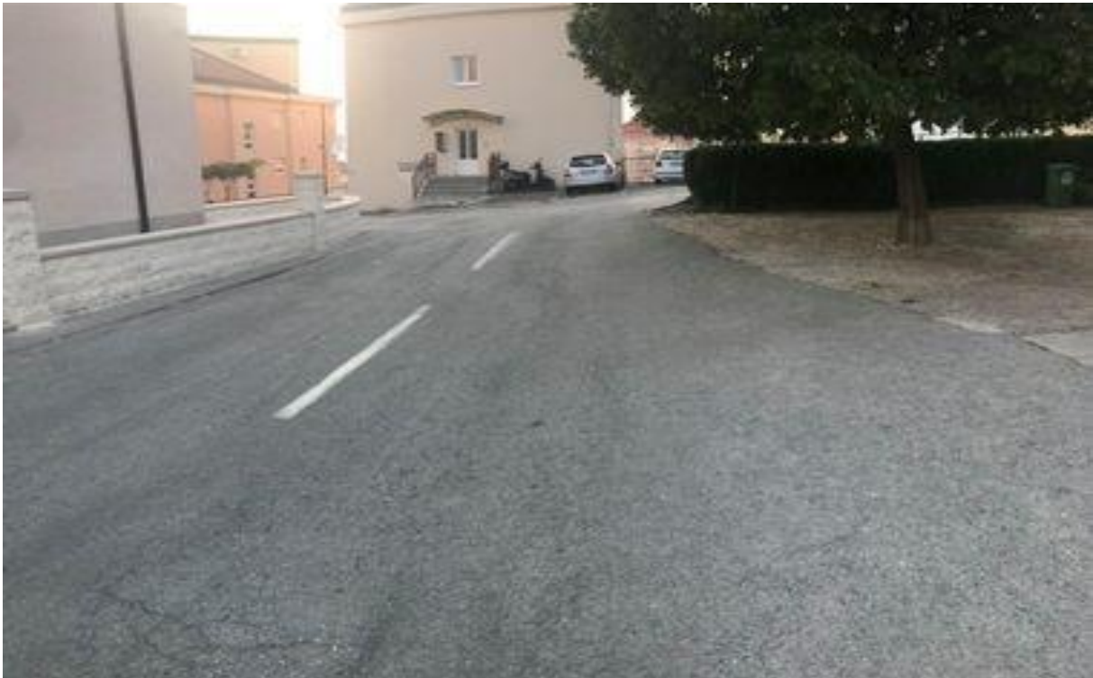
Slika 23. Prikaz T raskrižja „bez kontrole prometa“ sa smanjenom vidljivošću
