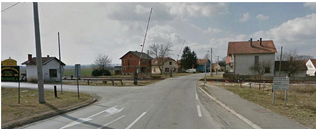
Slika 21. Željezničko – cestovni prijelaz
