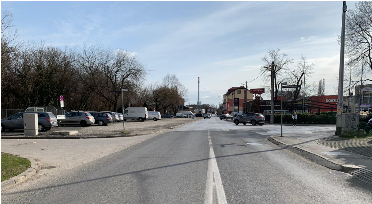
Slika 6. Fotodokumentacija postojećeg stanja - sjeverozapadni privoz (Tomislavova ulica)
