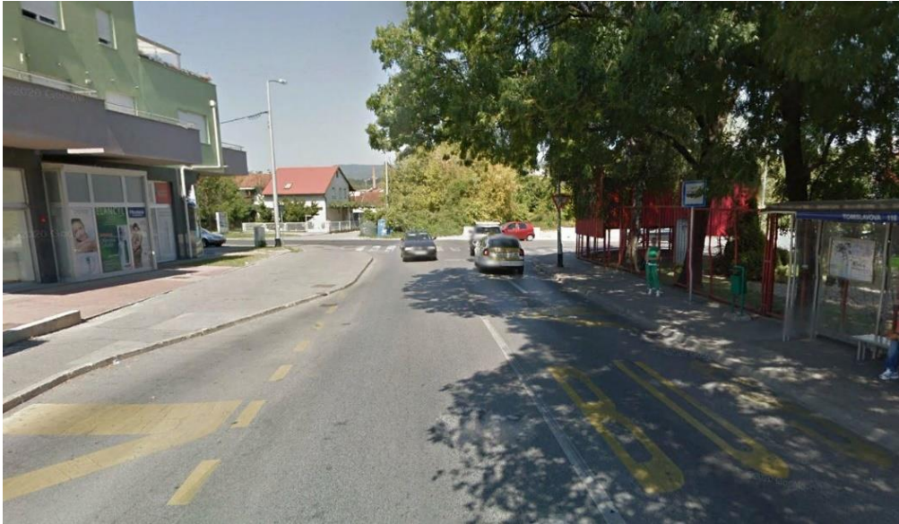
Slika 8. Fotodokumentacija postojećeg stanja - južni privoz (Ulica Dragutina Golika)
