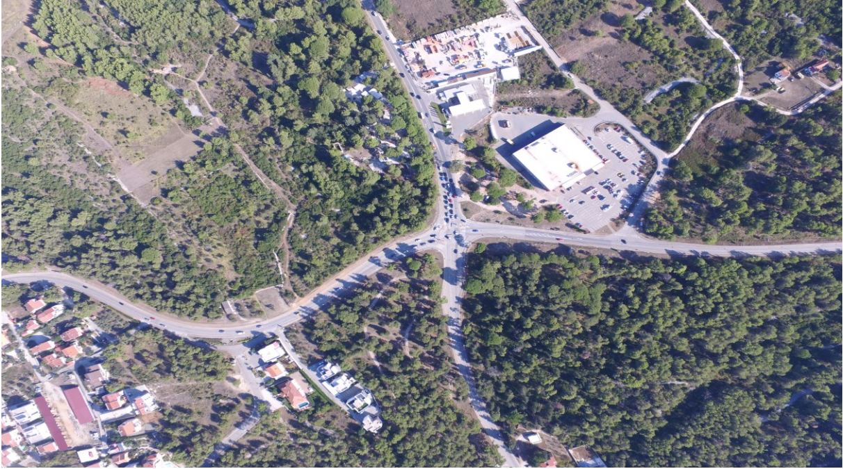
Slika 3.1. Postojeće stanje iz zraka
