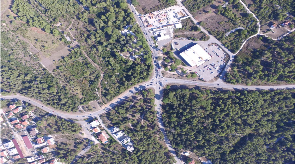
Slika 3.1. Postojeće stanje iz zraka
