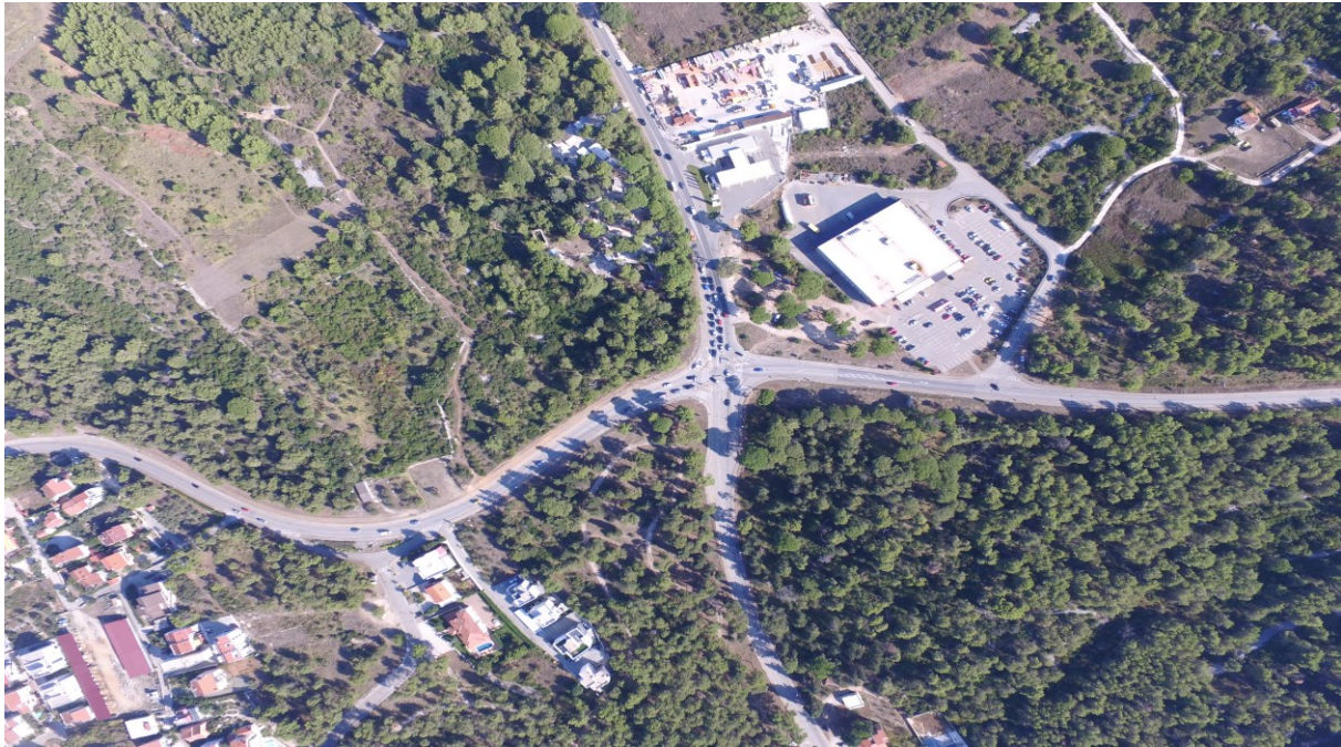
Slika 3.1. Postojeće stanje iz zraka
