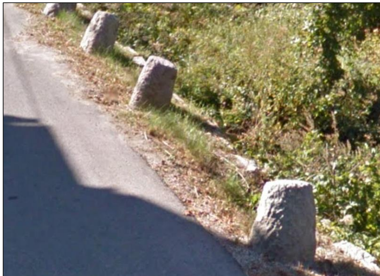
Slika 16. Ostaci kamenih kolobrana na dionici Karoline kod Zlobina (I. Ivanić, 2015.)
