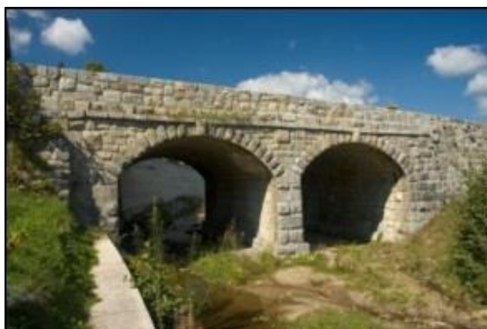
Slika 35. Kameni svođeni most s dva otvora na Luzijanskoj cesti kod Homera blizu Lokvi preko potoka Križ [30]
