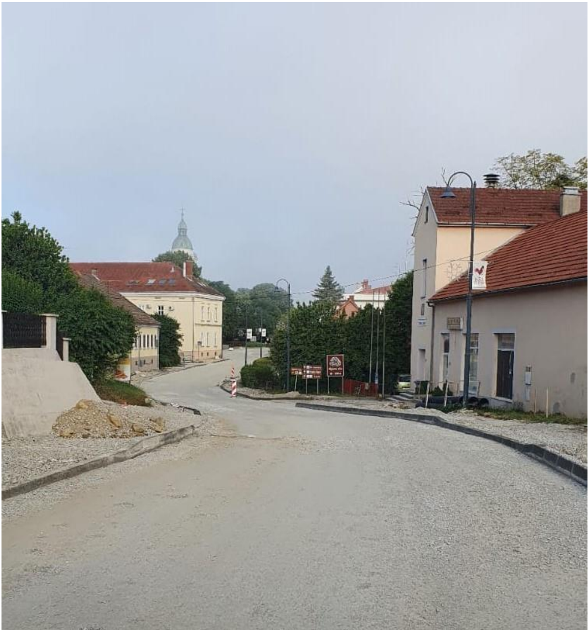
Slika 7. Modernizacija državne ceste DC307
