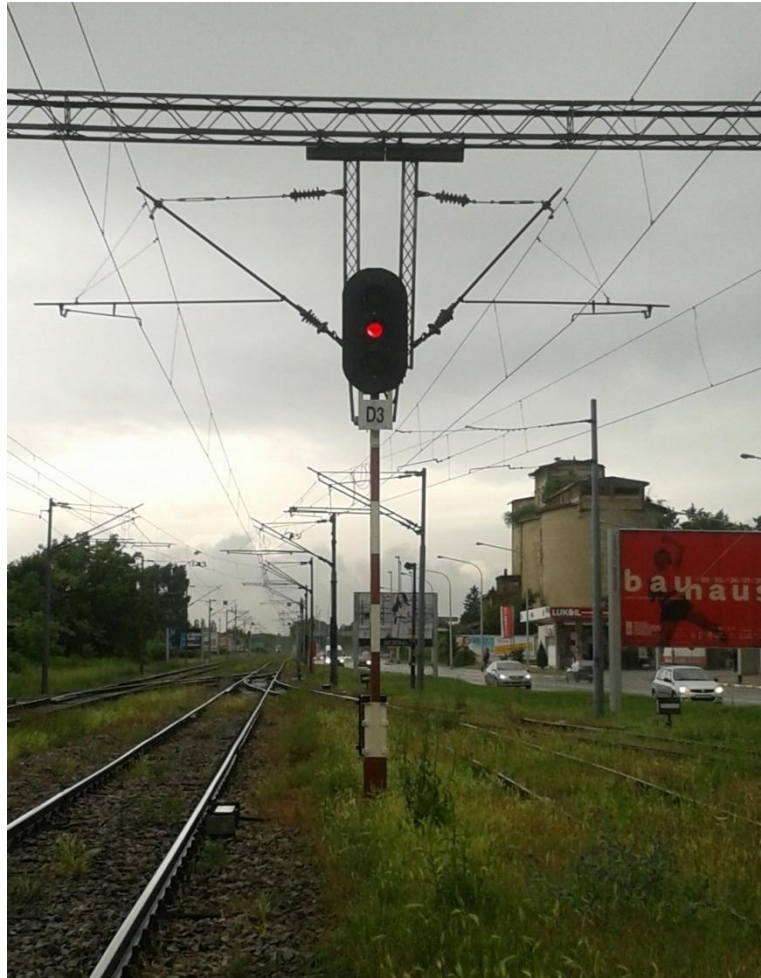
Slika 9 .Izlazni kolosiječni signal D3
