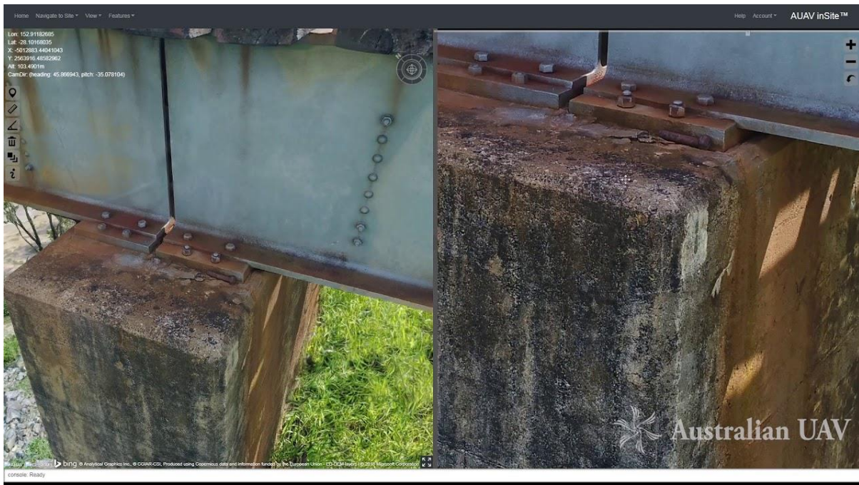
Slika 6. Pregled željezničkog mosta u svrhu pronalaza oštećenja primjenom 3D modela
