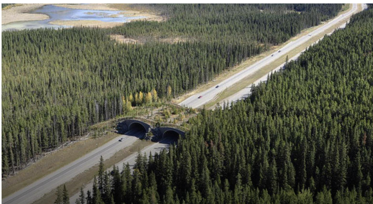
Slika 20. Zelena površina iznad tunela
