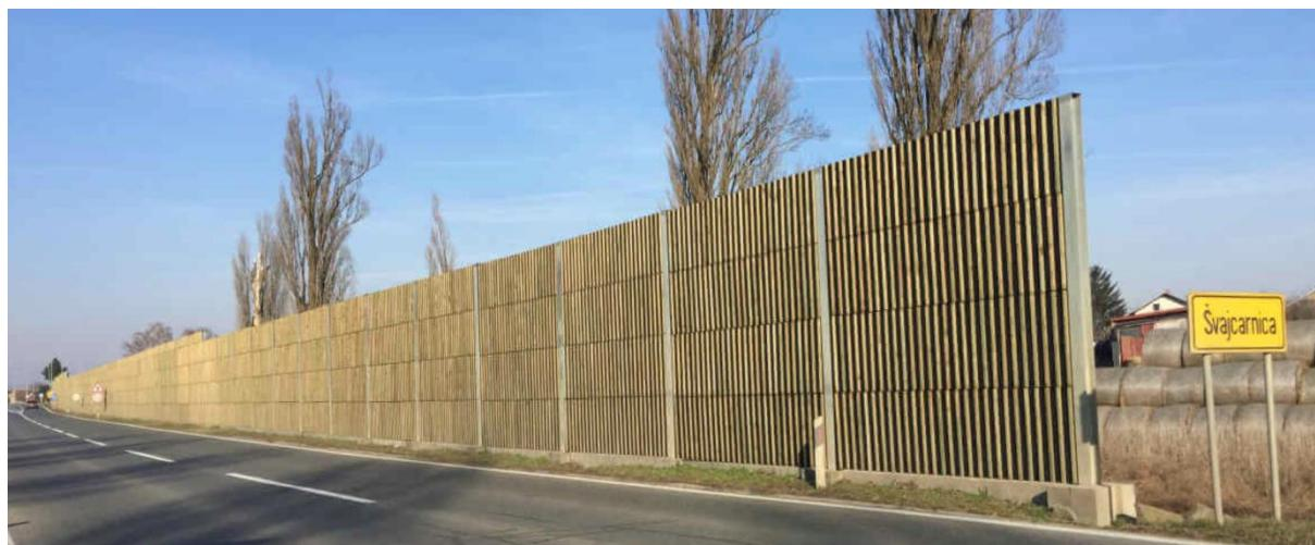
Slika 19. Primjer bukobrana izrađenog od drvenih panela, Švajcarnica-Osijek
