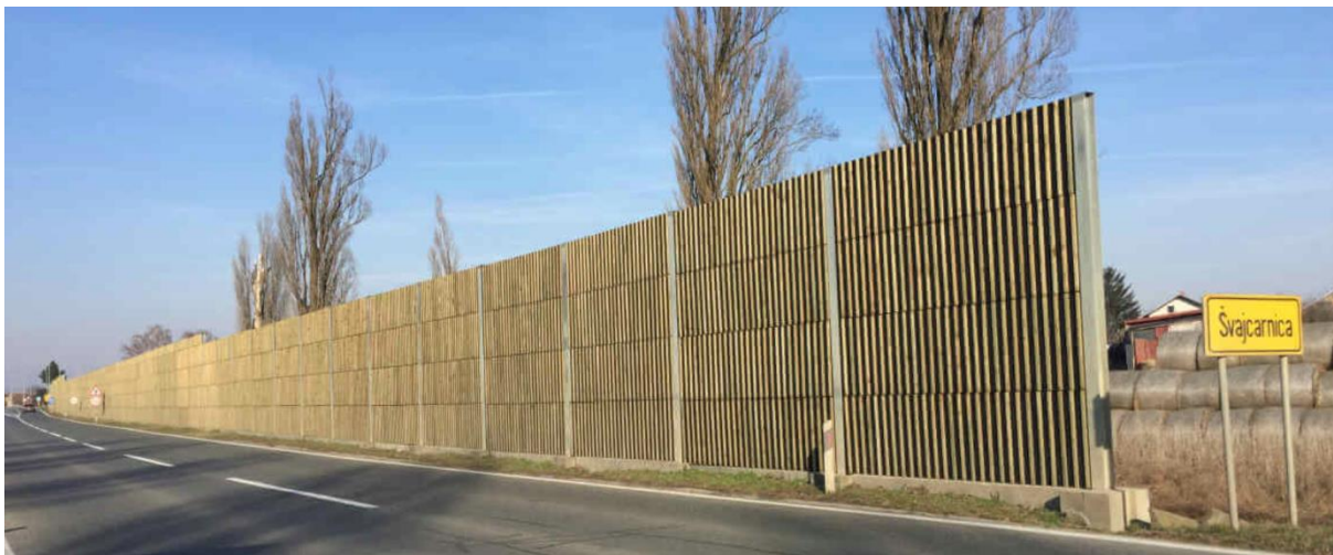
Slika 19. Primjer bukobrana izrađenog od drvenih panela, Švajcarnica-Osijek
