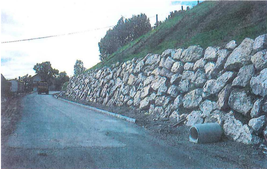
Slika 9. Potporni zid od velikog kamenja u suhozidu u Waldviertel, Austrija Izvor: Marinović-Uzelac, A. Prostorno planiranje, Dom i svijet, Zagreb, 2001., p.365
