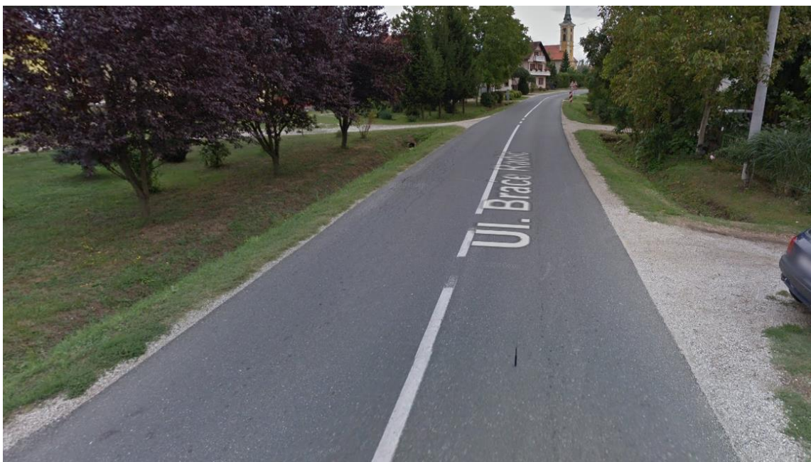
Slika 26. Nedostatak pješačke staze na županijskoj cesti Ž2071
