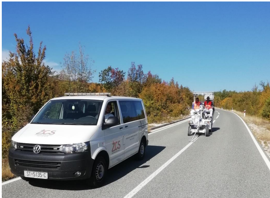
Slika 17: Bojanje uzdužne crte
