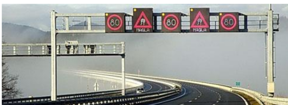
Slika 16. Prikaz PPZ-a na autocesti u Republici Hrvatskoj koji daje informaciju o meteorološkim uvjetima.
