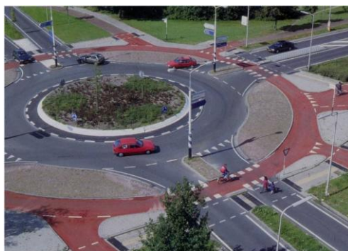
Slika 27. Prikaz zajedničkog vođenja biciklističkog i motornog prometa unutar raskrižja sa kružnim tokom prometa
