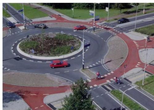
Slika 27. Prikaz zajedničkog vođenja biciklisčkog i motornog prometa unutar raskrižja sa kružnim tokom prometa
