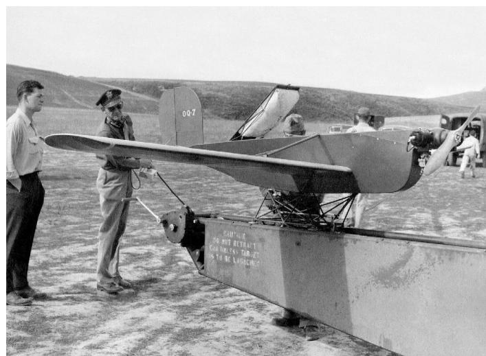
**Slika 4.** Bespilotna letjelica Radioplane OQ-2
