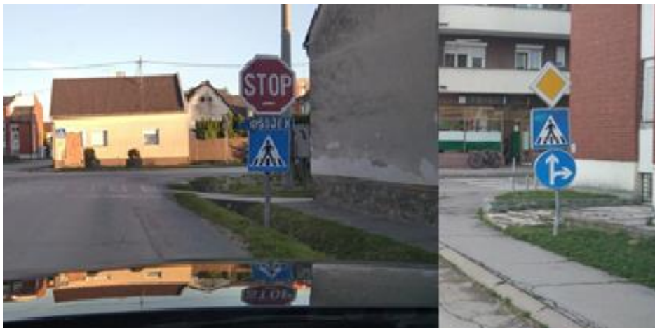
Slika 21. Primjer postavljanja više od 2 prometna znaka na istom nosivom stupu
