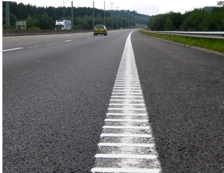
Slika 7. Oznake od termoplastike
