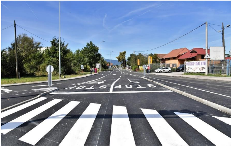
Slika 3. Poprečne oznake na kolniku
