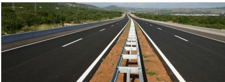
Slika 2. Uzdužne oznake na kolniku
