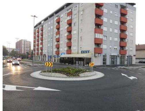
Slika 26. Zapadni privoz raskrižja 3 nakon rekonstrukcije
