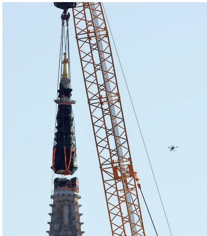
Slika 16. Prikaz uporabe bespilotnih letjelica za vrijeme skidanja tornja zagrebačke katedrale
