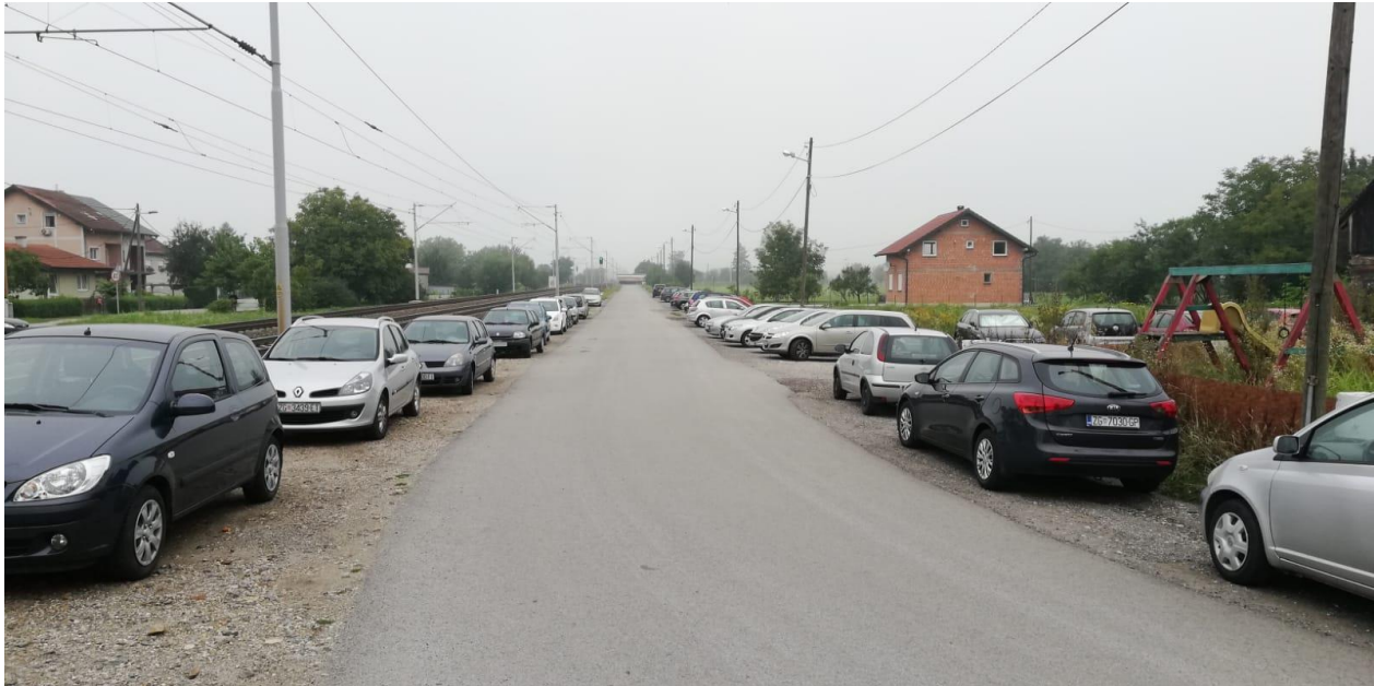
Slika 15. Željeznička ulica smjer prema zapadu
