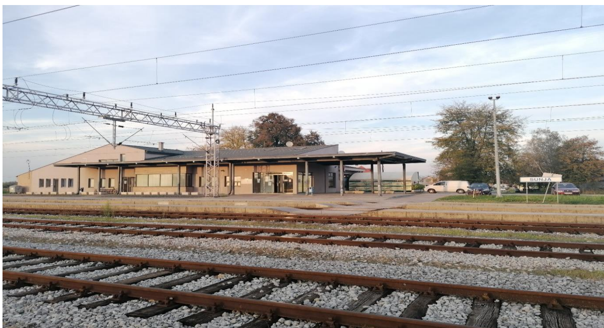
Slika 4. Kolodvorska zgrada kolodvora Sunja
