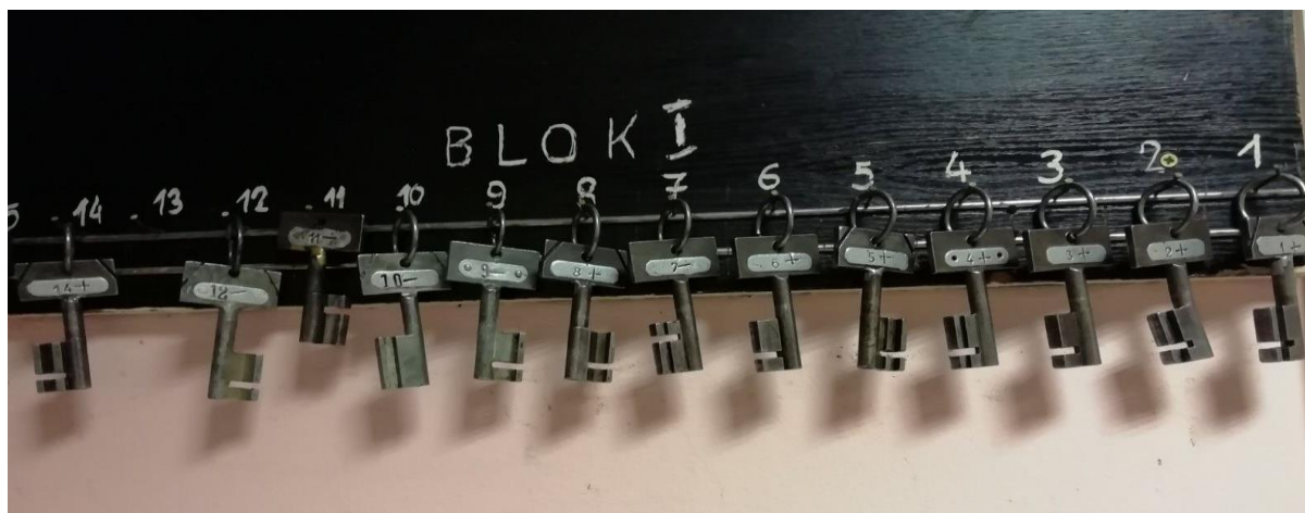
Slika 15. Ključevi skretnica od strane bloka 1
