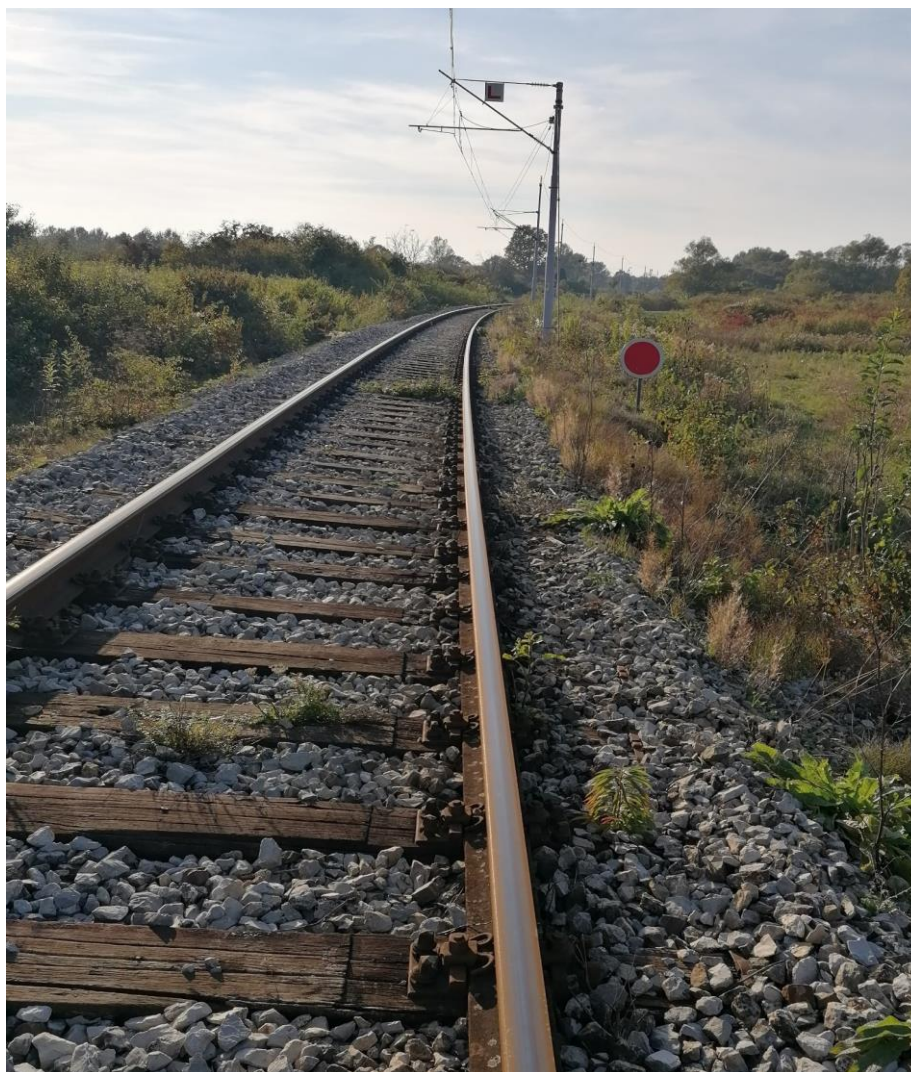
Slika 8. Crveni signalni lopar na mjestu ulaznog signala „A“ kolodvora Hrvatska Dubica
