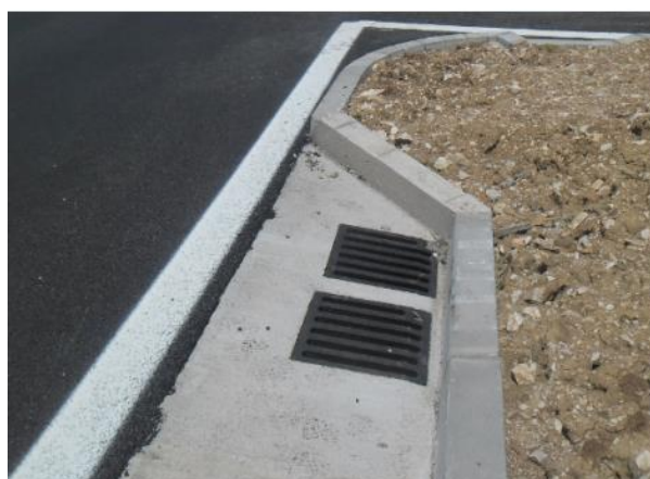
Slika 8. Prikaz odvodnje površinskih oborinskih voda
