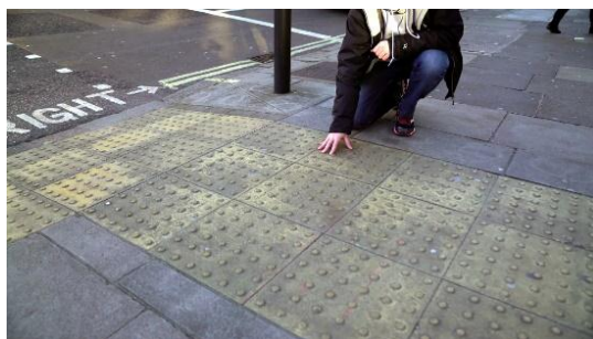
Slika 5. Izgled prilagođenih javnih prometnih površina za osobe s invaliditetom, [10]
