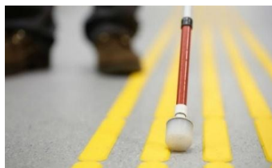
Slika 16. Zvučna taktilna površina na nizozemskim željezničkim postajama, [33]
