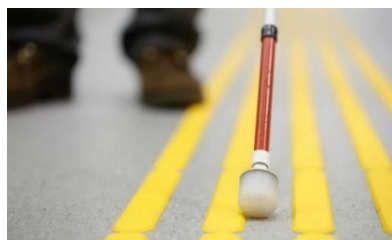
Slika 16. Zvučna taktilna površina na nizozemskim željezničkim postajama, [33]
