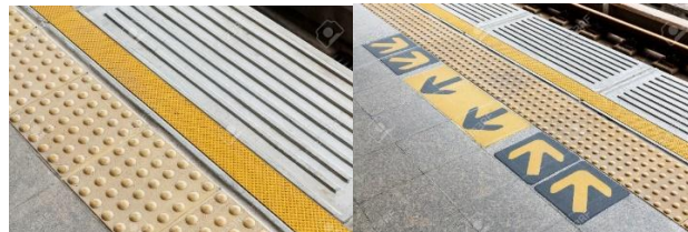
Slika 15. Taktilna površina na željezničkom peronu sa i bez strelica za usmjeravanje, [32]
