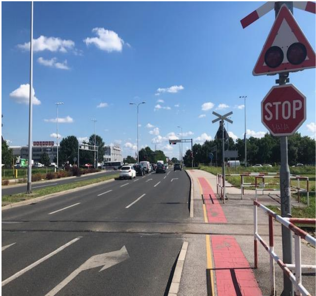
Slika 17 Sjeverni privoz – Ul. Siniše Glavaševića
