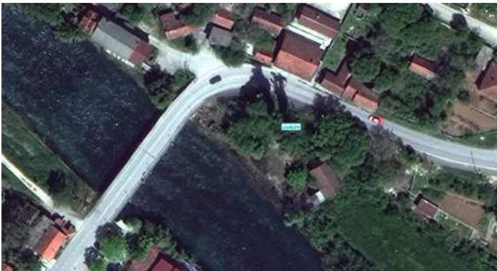
Slika 31. Zavoj na ulazu/izlazu s Baginog mosta u naselju Humac
