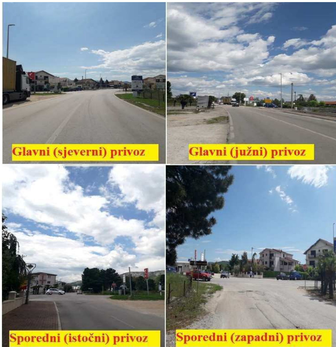
Slika 38. Pogled na privoze raskrižja 4
