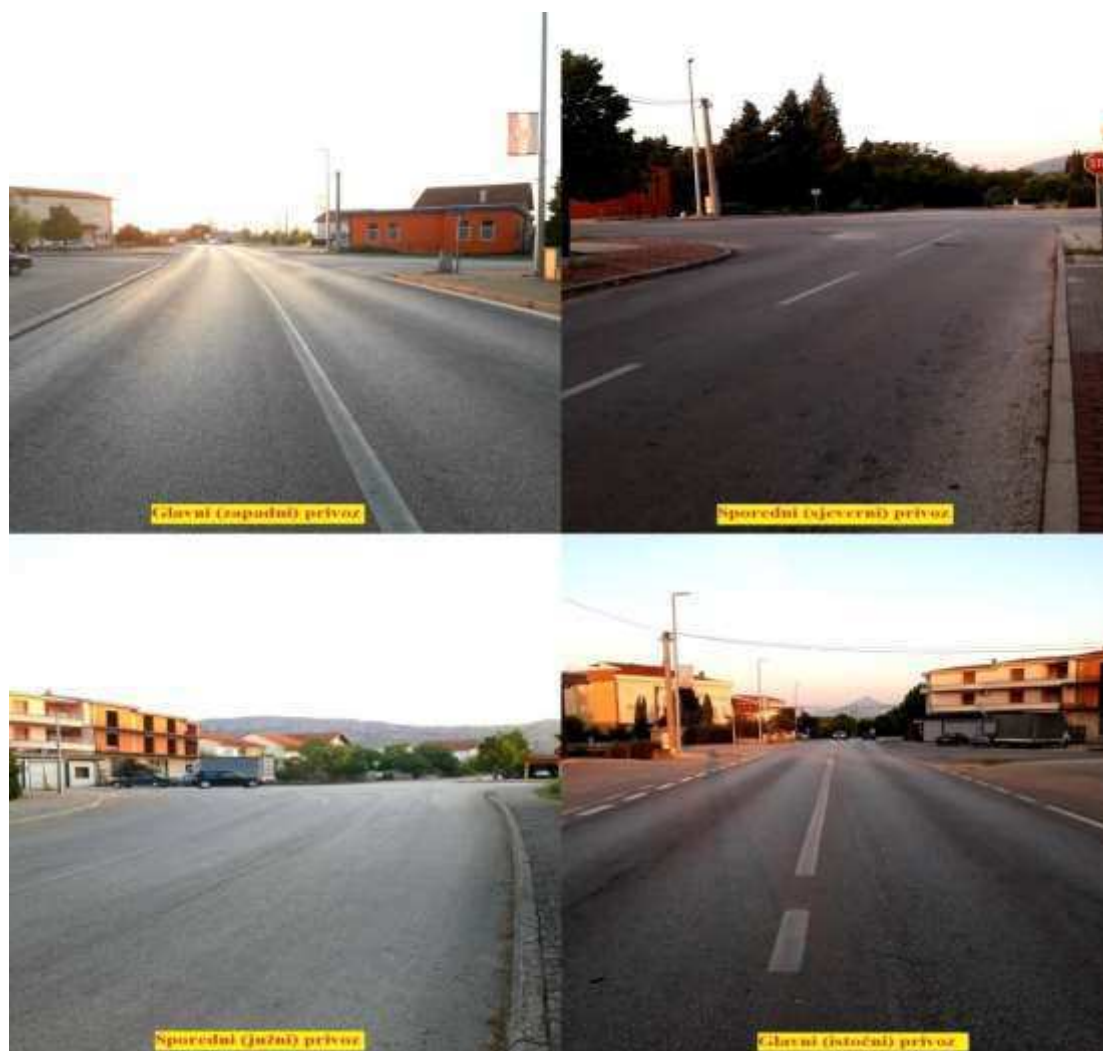
Slika 39. Pogled na privoze raskrižja 5
