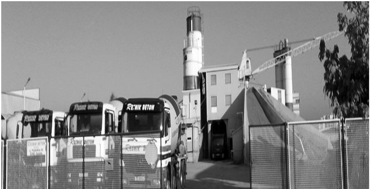
Slika 1. Tvrtka Resnik- Beton
