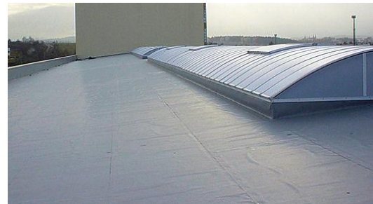
Slika 26. Krov s bijelim EPDM membranama.
