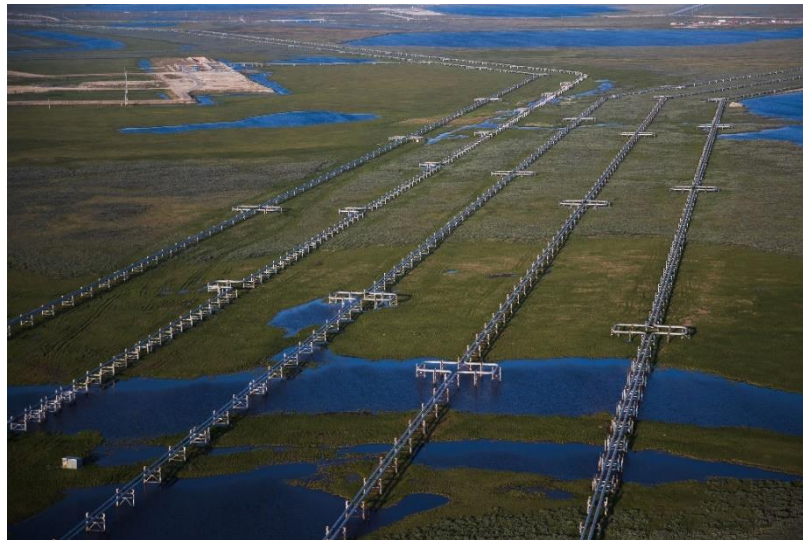
Slika 4. Cjevovodi za prijenos plina na Bonavenskovskom polju Izvor: https://www.gazprom.com/about/
