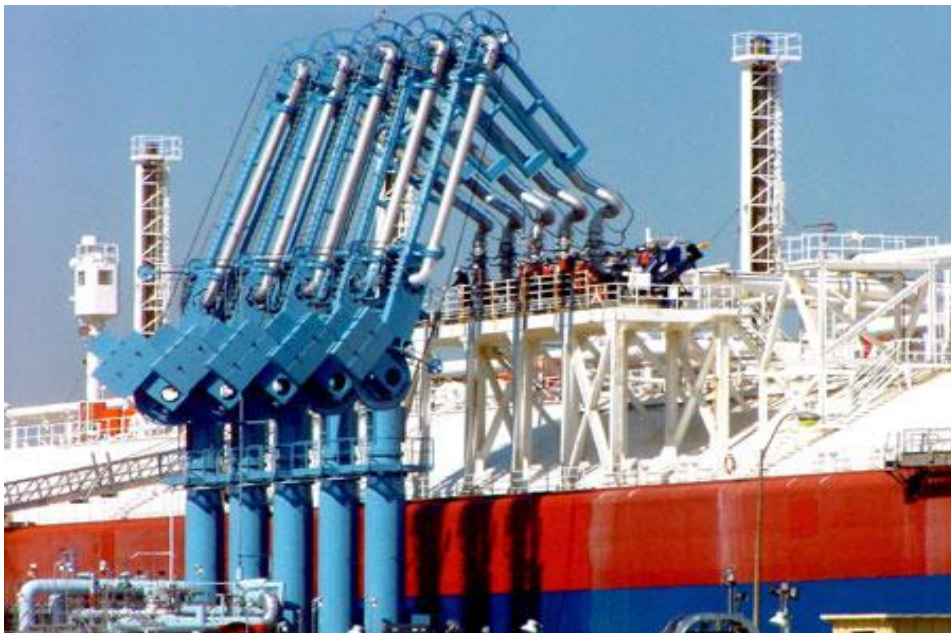
Slika 62. Prekrcaj tekuće rasute biomase sa pretakačkim rukama
