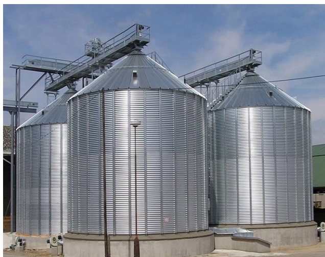
Slika 37. Silos sa ravnim dnom
