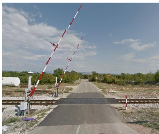
Slika 9. Željezničko cestovni prijelaz osiguran branikom [7]
