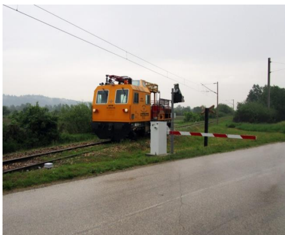
Slika 8. Željezničko cestovni prijelaz osiguran polubranikom [6]
