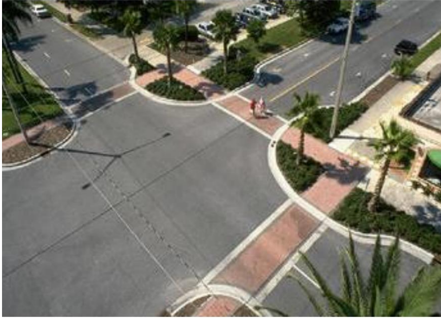
Slika 22: Primjer suženja vozne i proširenja pješačke površine
