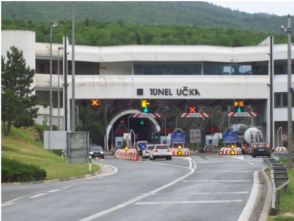
Slika 40. Portal tunela Učka, [30]
