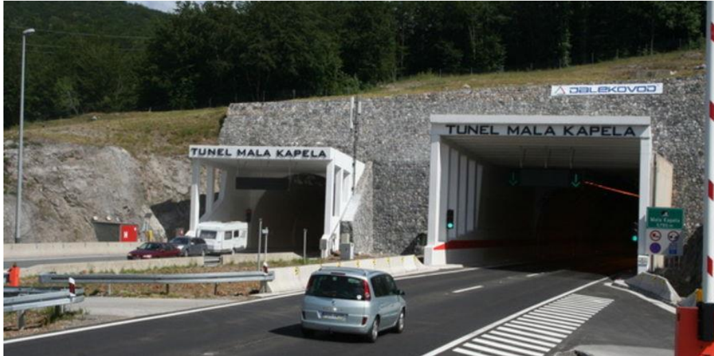
Slika 38. Portal tunela Mala Kapela, [2]
