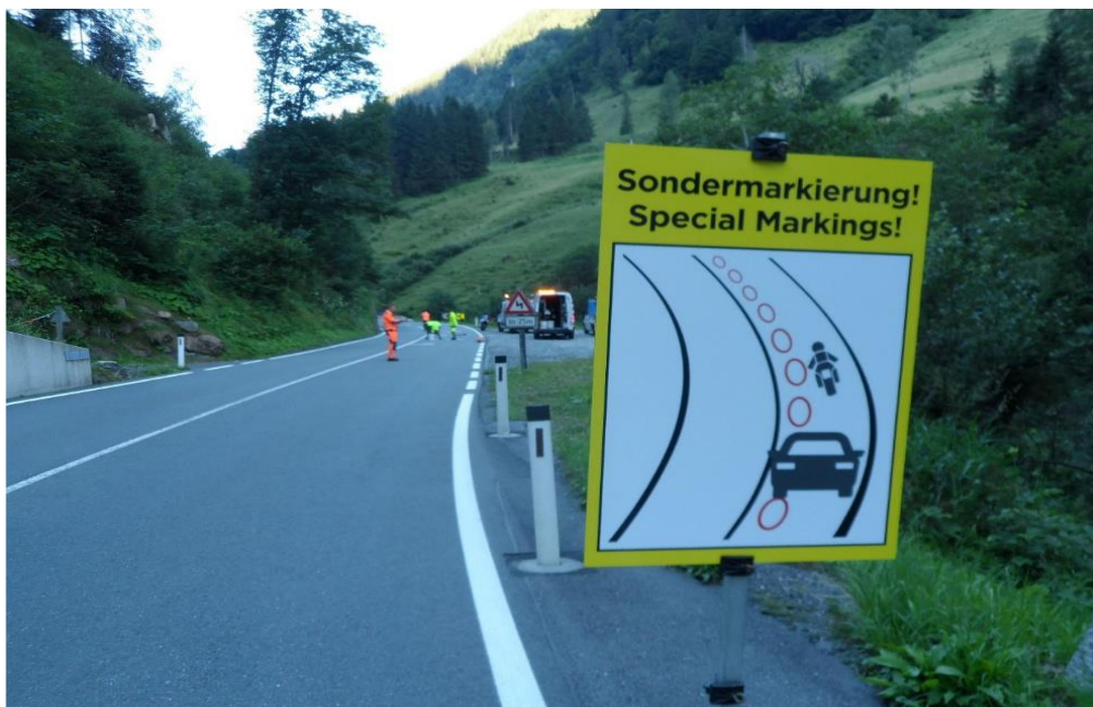
Slika 17. Prometni znak za upozoravanje na nailazak na specijalne oznake na kolniku namijenjene motociklistima
