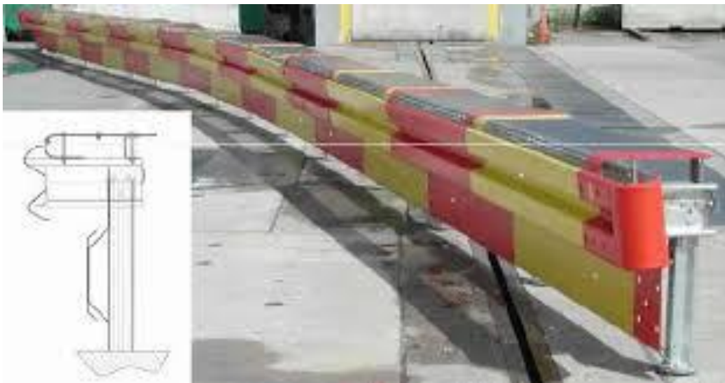
Slika 12. Dodatak na postojeću zaštitnu ogradu
