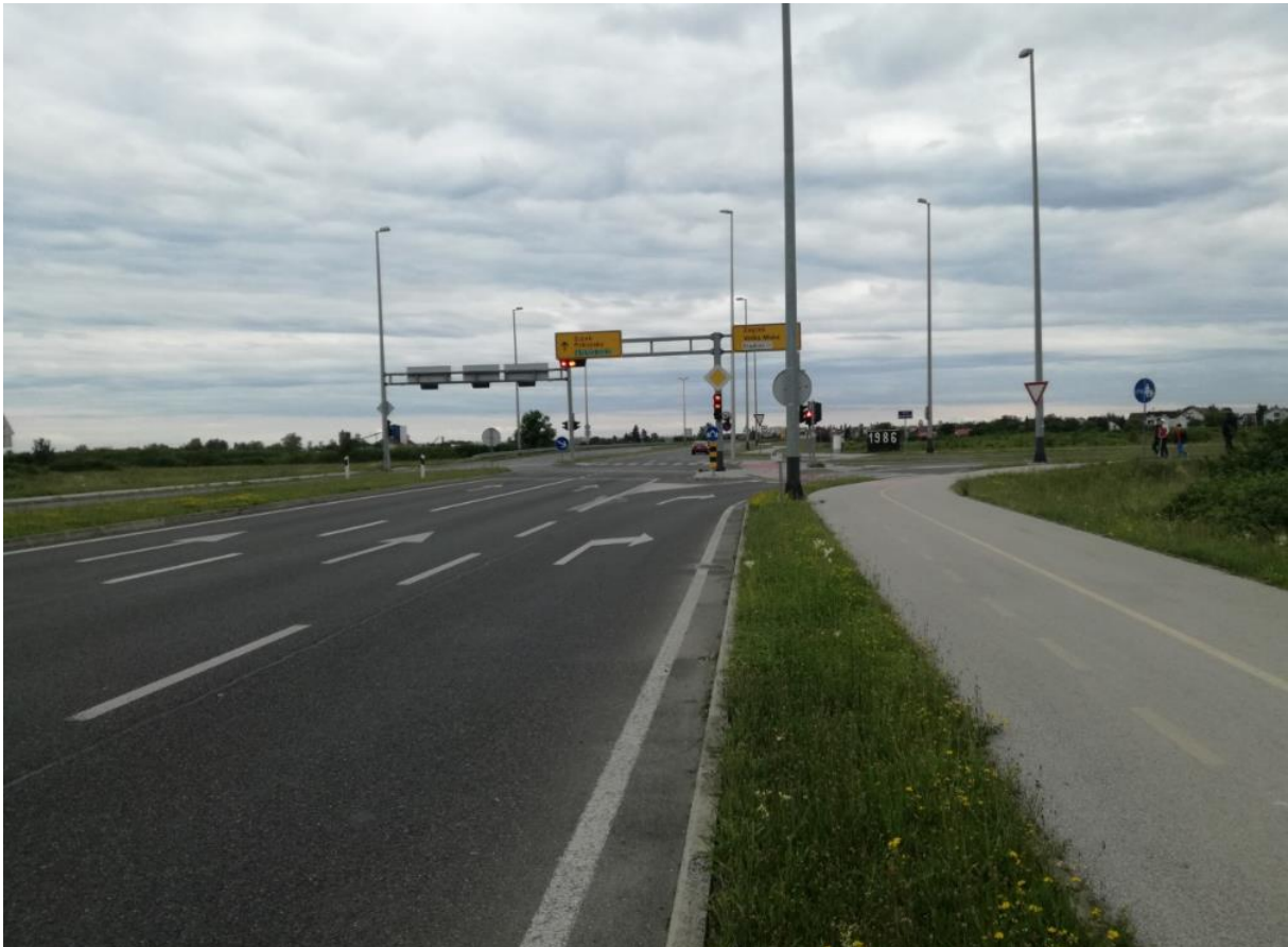
Slika 14. Prikaz Sjevernog kolnika državne ceste D-30
