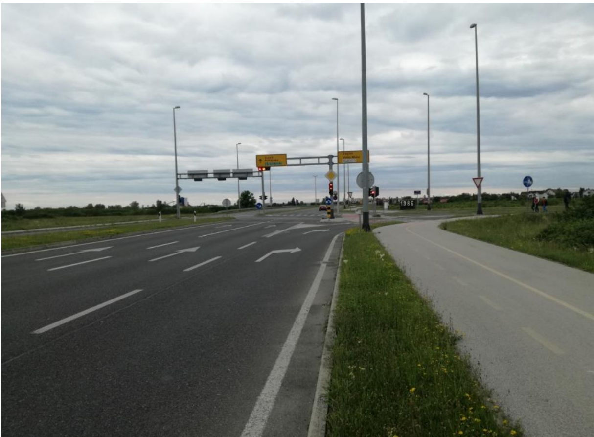
Slika 14. Prikaz Sjevernog kolnika državne ceste D-30
