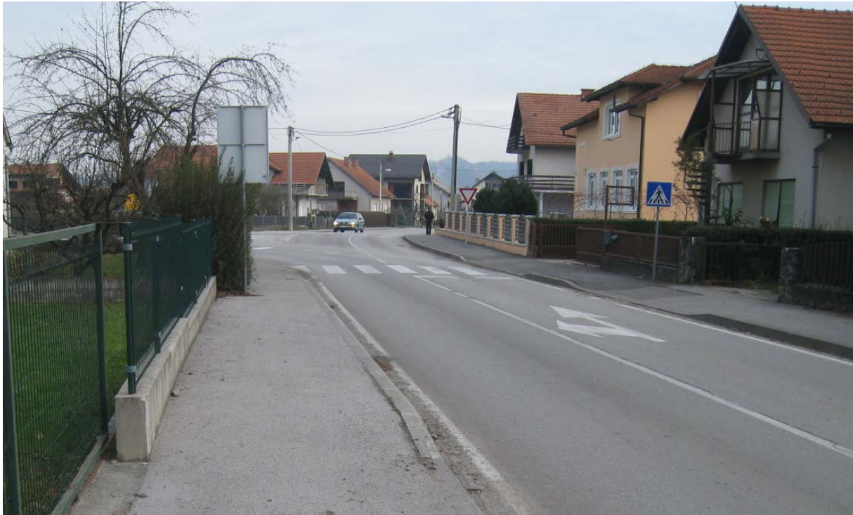
Slika 13: Prikaz stanja ceste i opreme - jugozapadni privoz [21]
