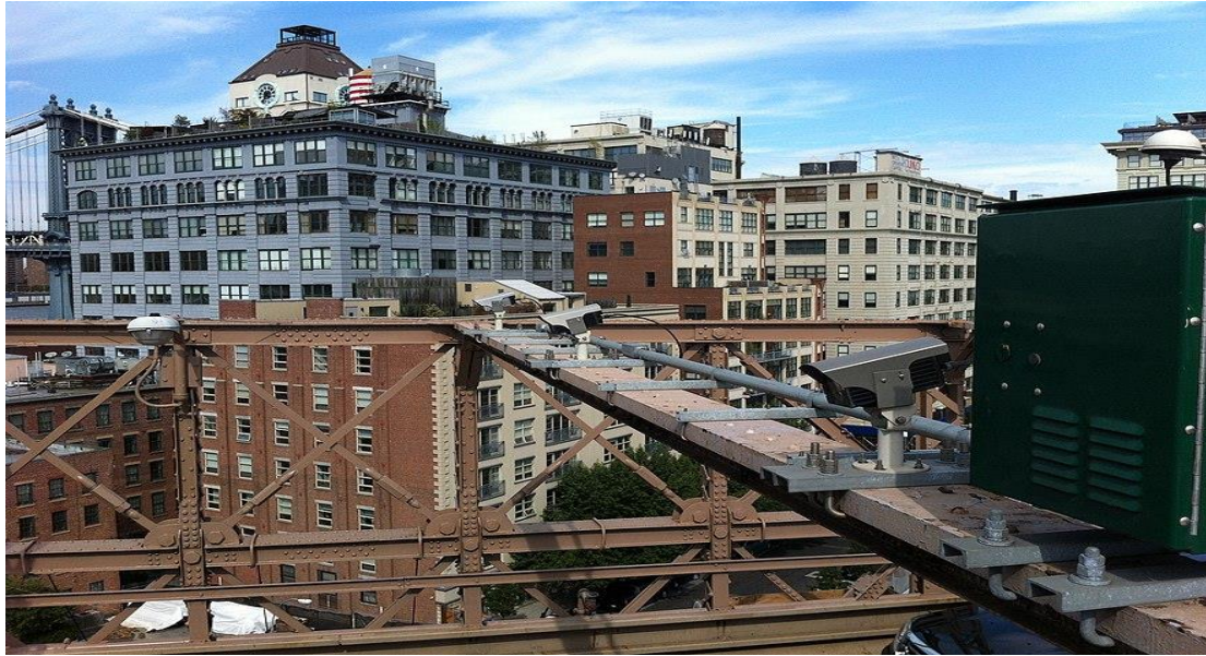
Slika 4. ANPR sustav kamera na Brooklyn Bridgeu u New Yorku
