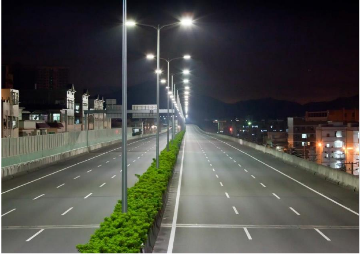
Slika 6: Centralni raspored izvora svjetlosti
