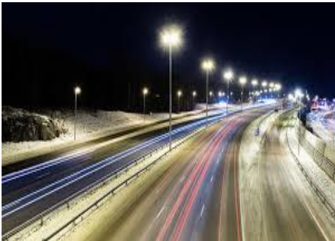
Slika 9: Kombinirani raspored izvora svjetlosti
