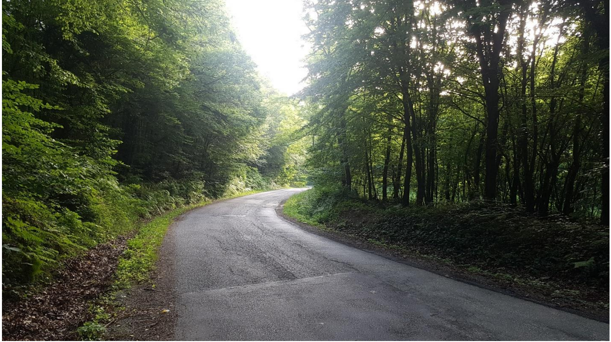
Slika 32. Horizontalna nepreglednost u zavojima
