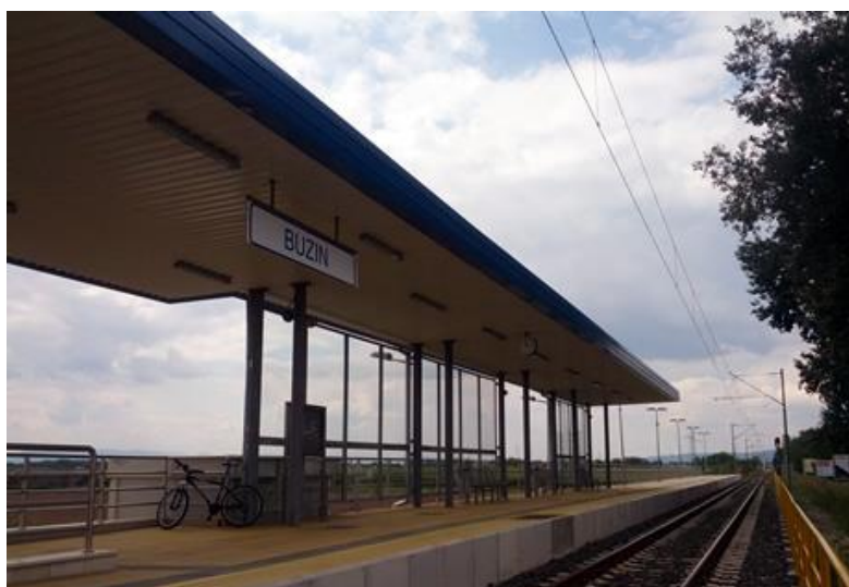
Slika 5-7 Željeznička stanica Buzin, Izvor [19]
